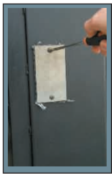
Løsn de 4 skruer for at skille panelerne ad
